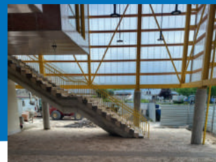
Obras do novo Mercado
