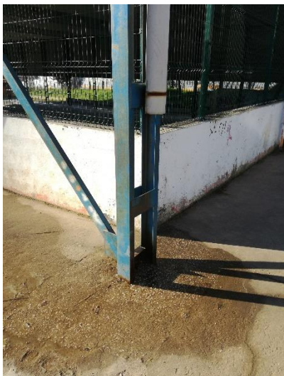
Escoamento da Estrutura metálica da cobertura do Pavilhão no espaço de recreio
