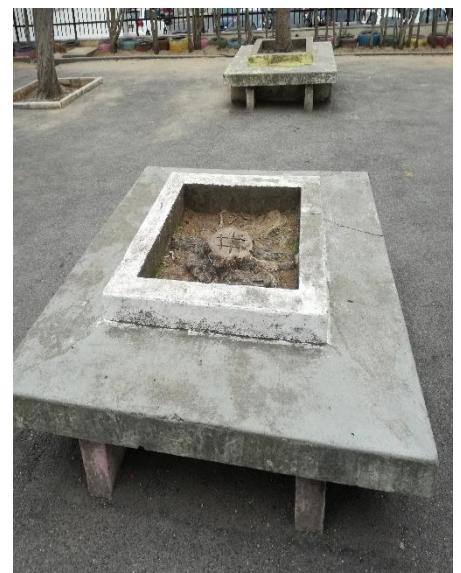
Bancos/caleiras em quina viva no espaço de recreio
