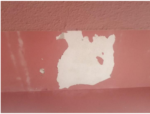
Pinturas exterior e interior em mau estado
