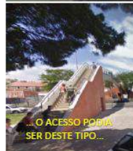
SITUANDO O ACESSO NA RUA 1º DE MAIO (Dafundo)
