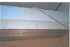
Passagem de Fio
