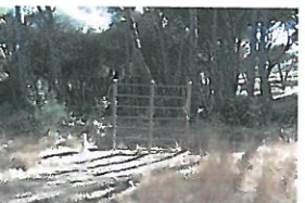
Equip. alguma degradação
