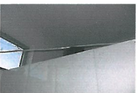
Passagem de fio dentro WCs
