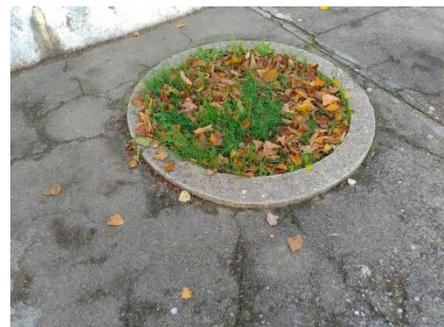
Os pavimentos exteriores - lajetas pré-fabricadas derrapantes, encontram-se degradados, com humidade e necessitam de ser substituídos. O único brinquedo existente não tem condições de utilização!
