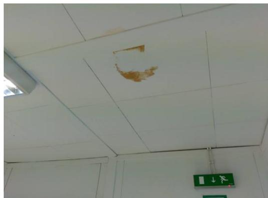
Uma escola em que as fachadas, a estrutura, os tectos e as paredes são em pré-fabricado e onde existem inúmeras persianas avariadas/partidas. O material existente no interior é desadequado a crianças de 4-5 anos e, quanto mais o tempo passa, mais se agravam os problemas de humidade e infiltrações nas salas de aula.
