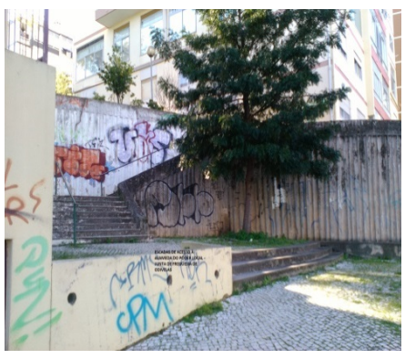
Foto: Escadas de acesso à Alameda do Poder Local
