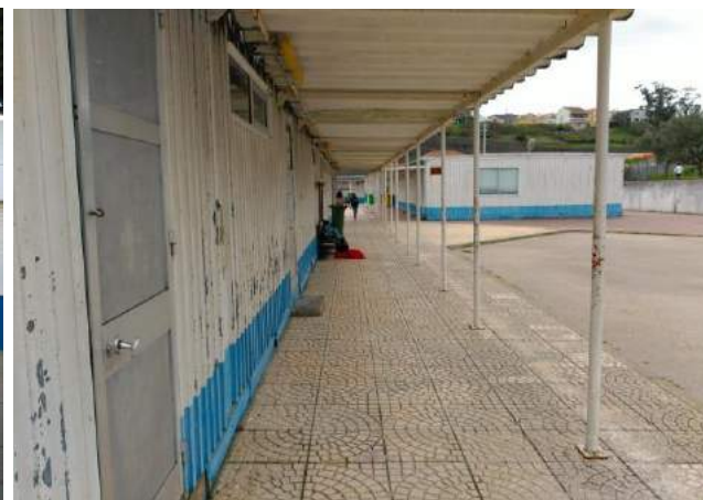
Pavilhões pré fabricados construídos provisoriamente nos anos 90
