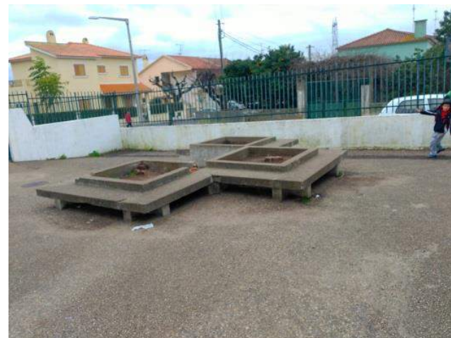
Espaço de recreio com canteiros desativados
