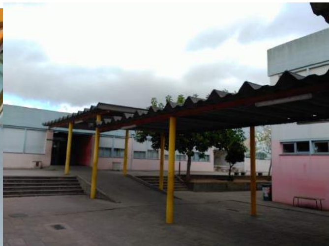
Coberturas de Fibrocimento
