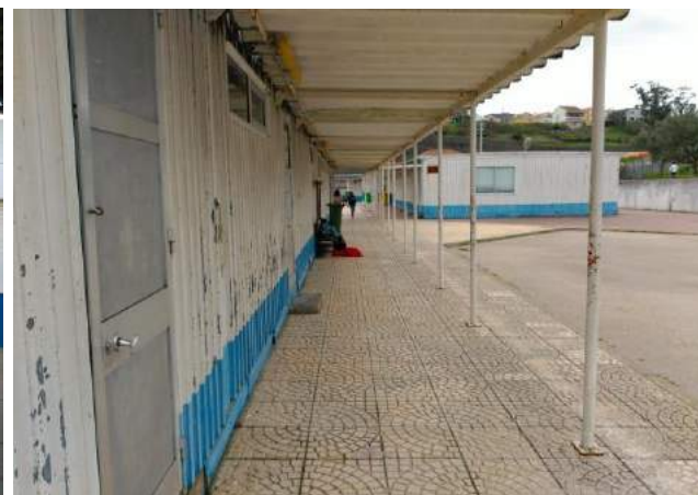
Pavilhões pré fabricados construídos provisoriamente nos anos 90
