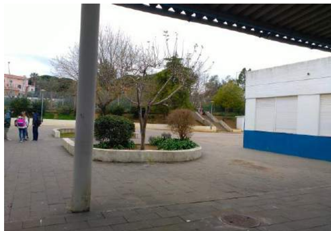
Espaços de recreio e cobertura de Fibrocimento
