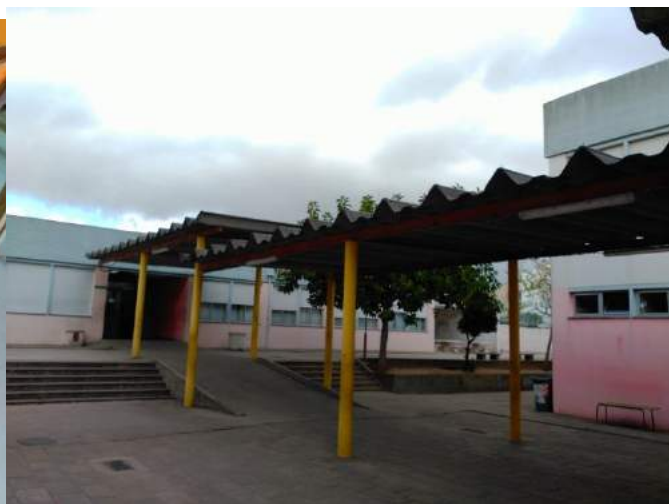
Coberturas de Fibrocimento
