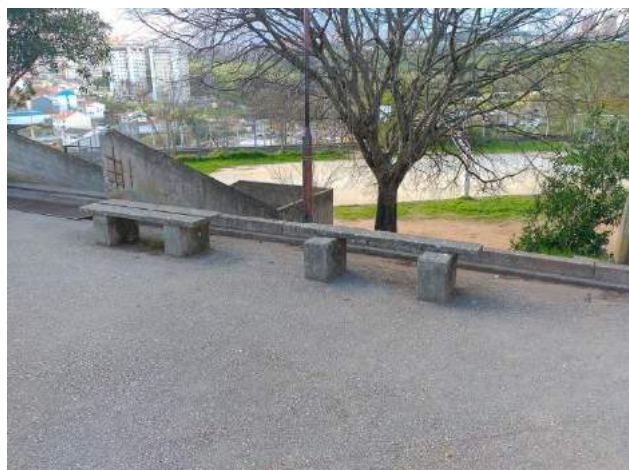
Bancos, escadas e espaço exterior “vencido pelo tempo” e degradado pela falta de manutenção
