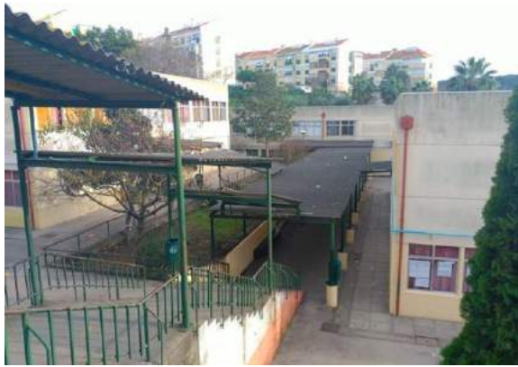
Coberturas em Fibrocimento que existem em toda a Escola
