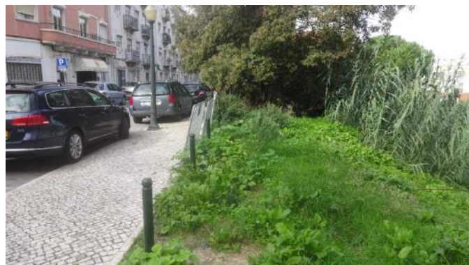
Imagem da falta de protecção junto a ravina, na Rua Paio Peres Correia — Outubro de 2014
