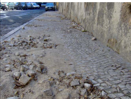
Este é o estado em que se encontram muitos passeios em Lisboa
